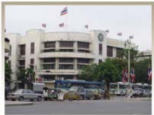
ภาพแสดงก่อนการปรับปรุงทาสีอาคารบริเวณริมถนนราชดำเนิน
