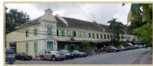
ภาพแสดงหลังการปรับปรุงทาสีอาคารบริเวณริมถนนอัษฎางค์
