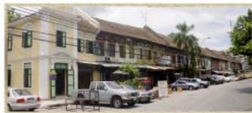
ภาพแสดงก่อนการปรับปรุงทาสีอาคารบริเวณริมถนนอัษฎางค์
